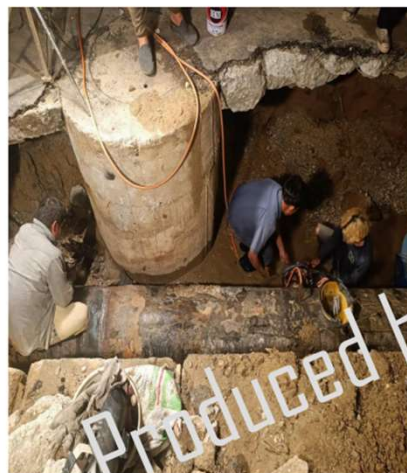
Repaired Leak (จุดรั่วที่ซ่อมแล้ว)
